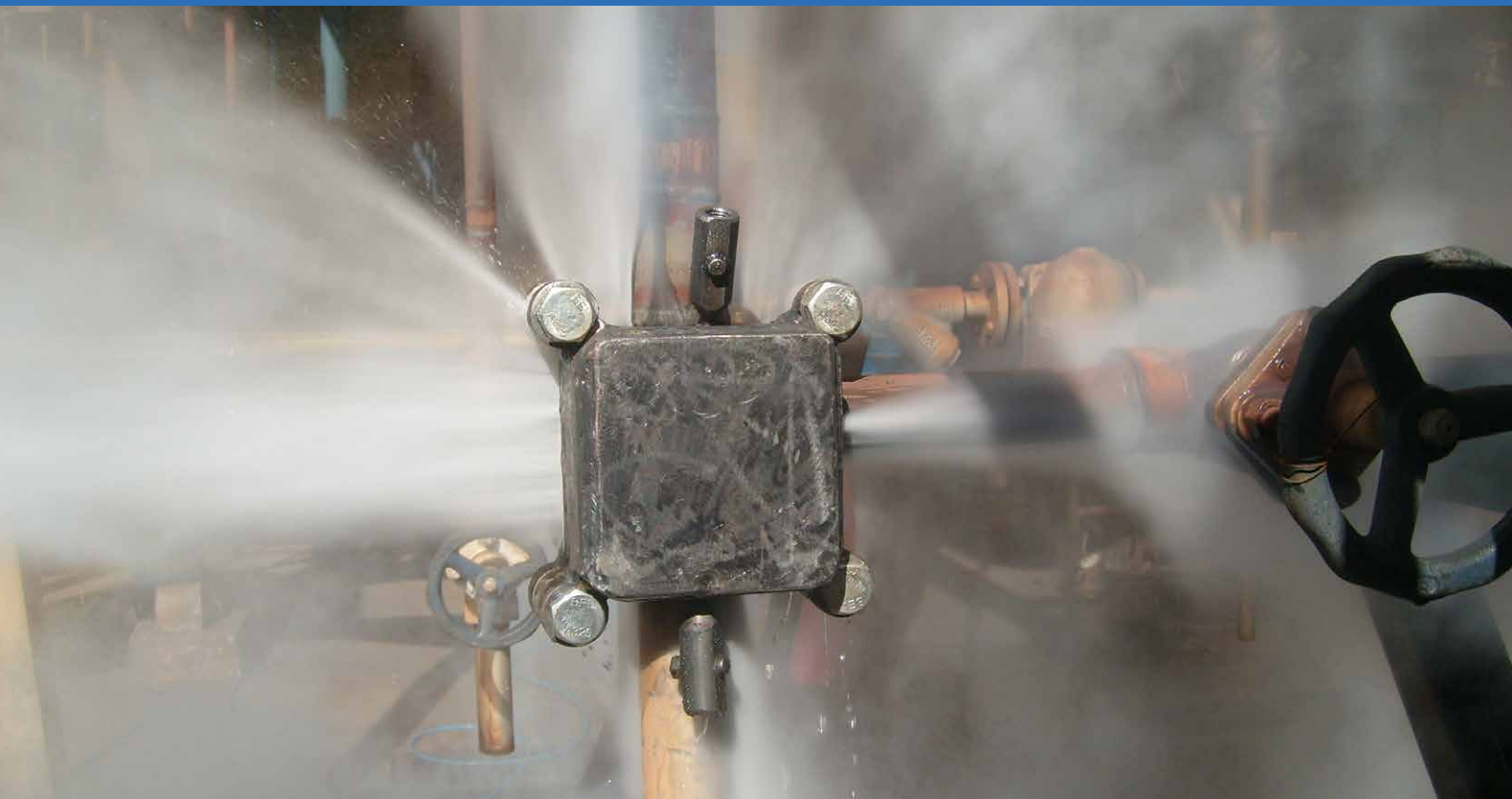
VAZAMENTO DE VAPOR EM ALTA PRESSÃO E TEMPERATURA
