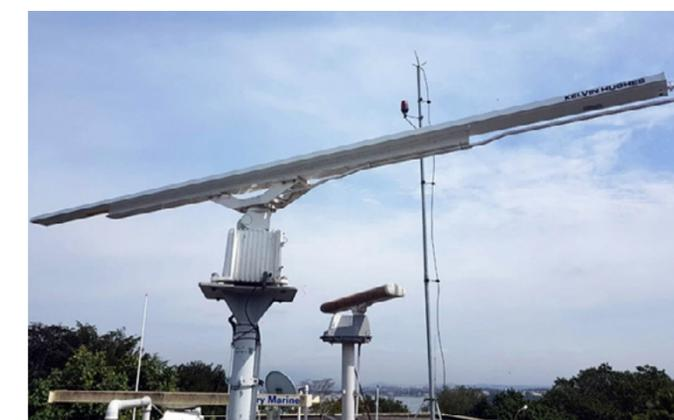
A Metallock Brasil foi chamada para realizar troca de antena do Radar Banda X de importante Centro de Pesquisas, no Rio de Janeiro. Esse equipamento é integrado ao Serviço de Tráfego de Embarcações de fabricação da Kelvin Hughes.
