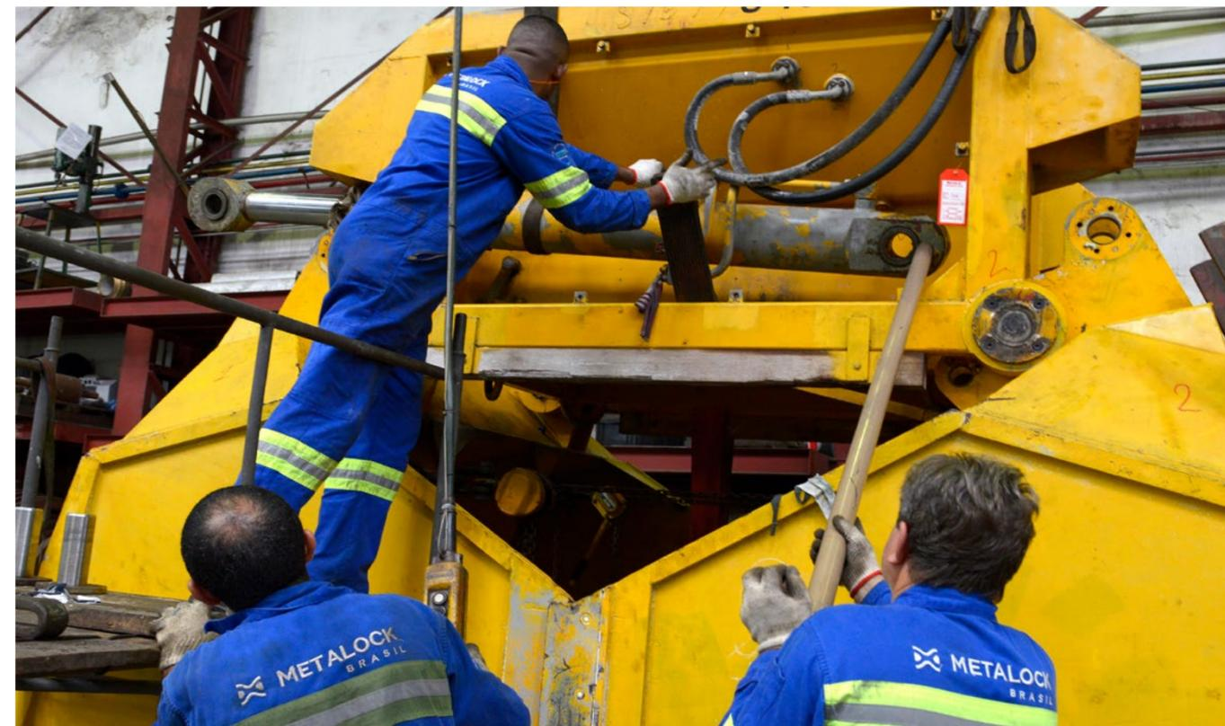
A Metalock Brasil foi solicitada para realizar reparo em descarregador de navios tipo caçamba de mandíbulas. Estes tipos de equipamentos são projetados para descarregar embarcações de vários tamanhos, em um mesmo terminal.
